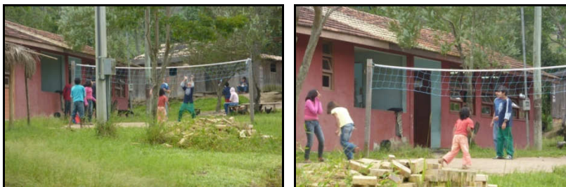
Figuras 21: vistas do pátio frente à escola e posto de saúde ao fundo
