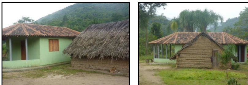
Figuras 56: Tipologias construídas em Marangatu
