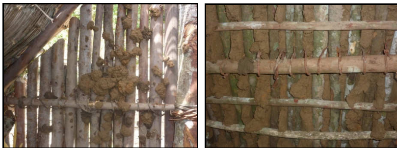
Figuras 39: Parede de pau-a-pique sendo recoberta com barro
