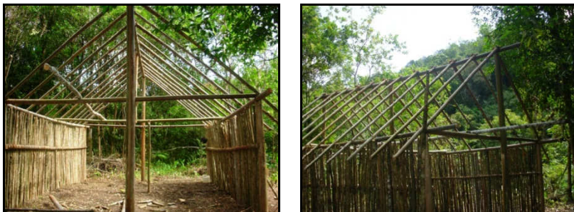
Figuras 33: Estrutura de troncos roliços
