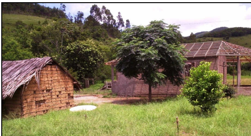
Figura 55: Casa Tradicional e Habitação Social em construção – Marangatu
