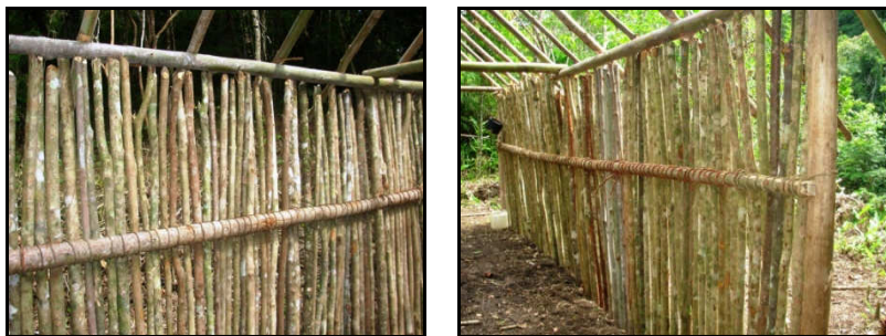
Figuras 36: Detalhe vedação pau-a-pique
