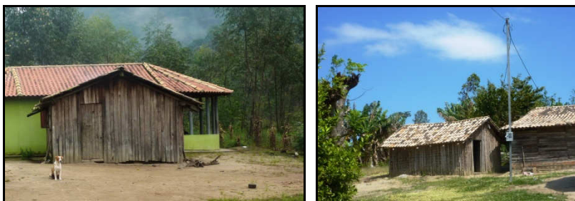
Figuras 26: Edificações em madeira.
