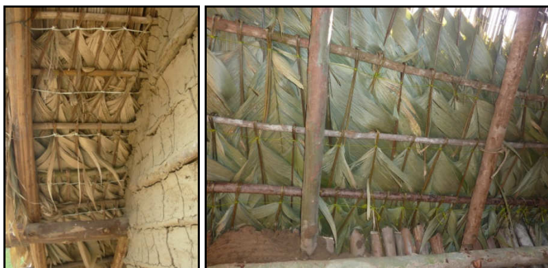
Figuras 43: Vista da cobertura na parte interna com as amarrações em fio sintético
