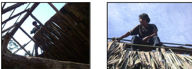
Figuras 44: Construção de telhado de taquara batida
