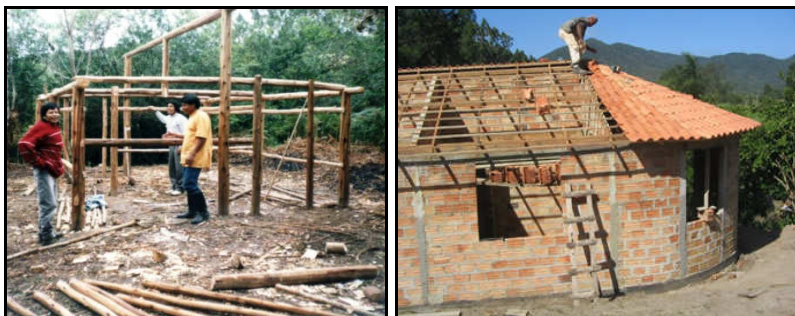
Figuras 59: Mbyá-Guarani construindo em mutirão e trabalhador de empresa licitada construindo as HIS.
